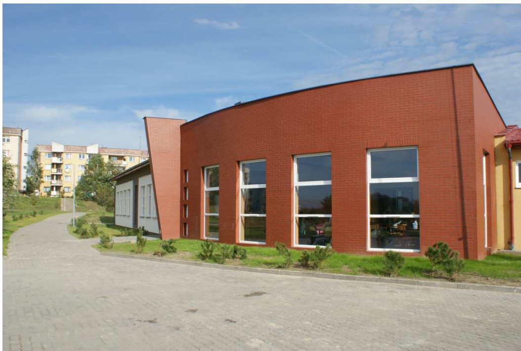
Rozbudowana część Szkoły Podstawowej nr 2
