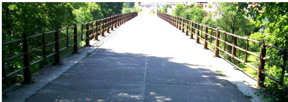
Fot. 16. Widok na obie balustrady i asfaltową nawierzchnię, wylaną między granitowymi płytami gzymsów koronujących elewacje.
