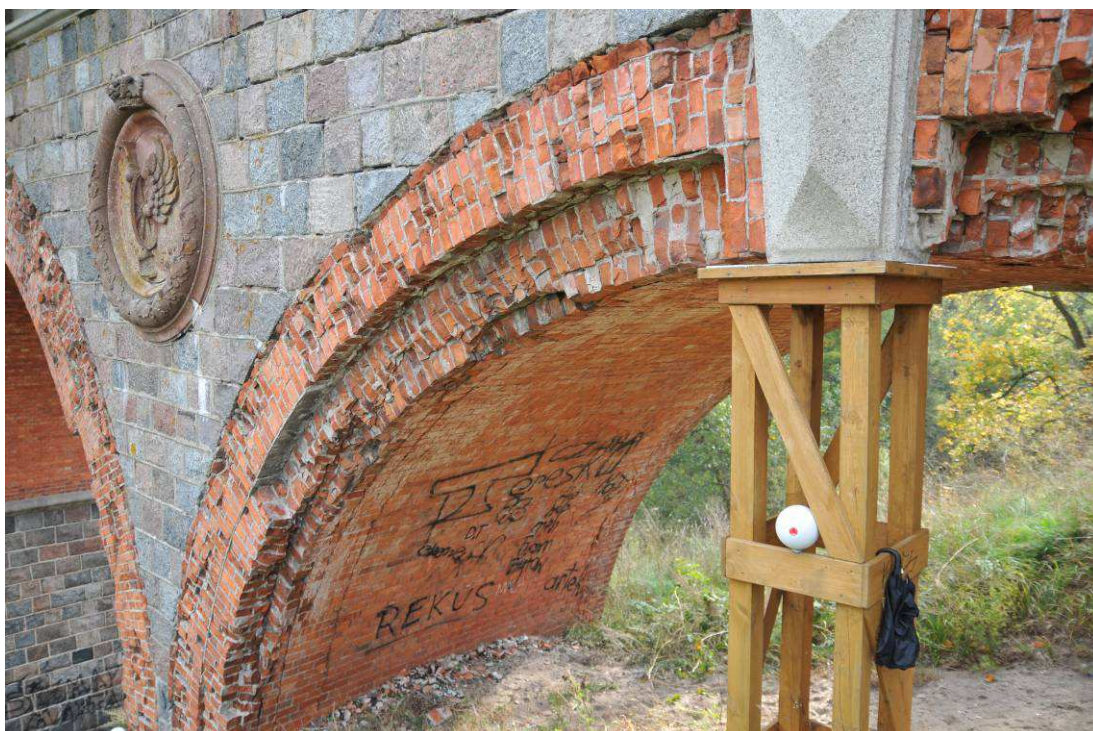
Fot. 5. Osiadająca arkada podparta drewnianą konstrukcją
