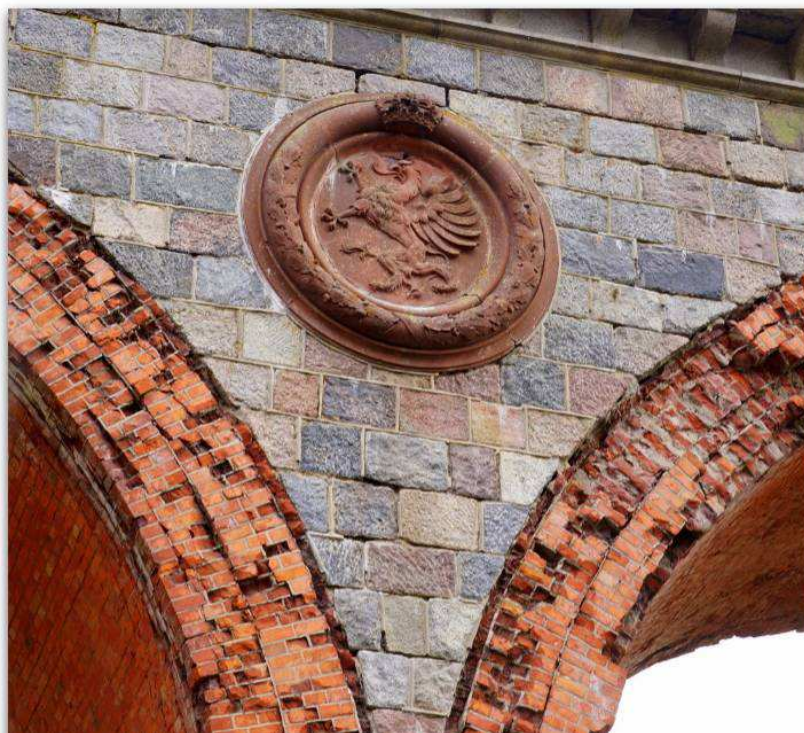
Fot. 4. Fragment elewacji zachodniej z herbem Pomorza.
