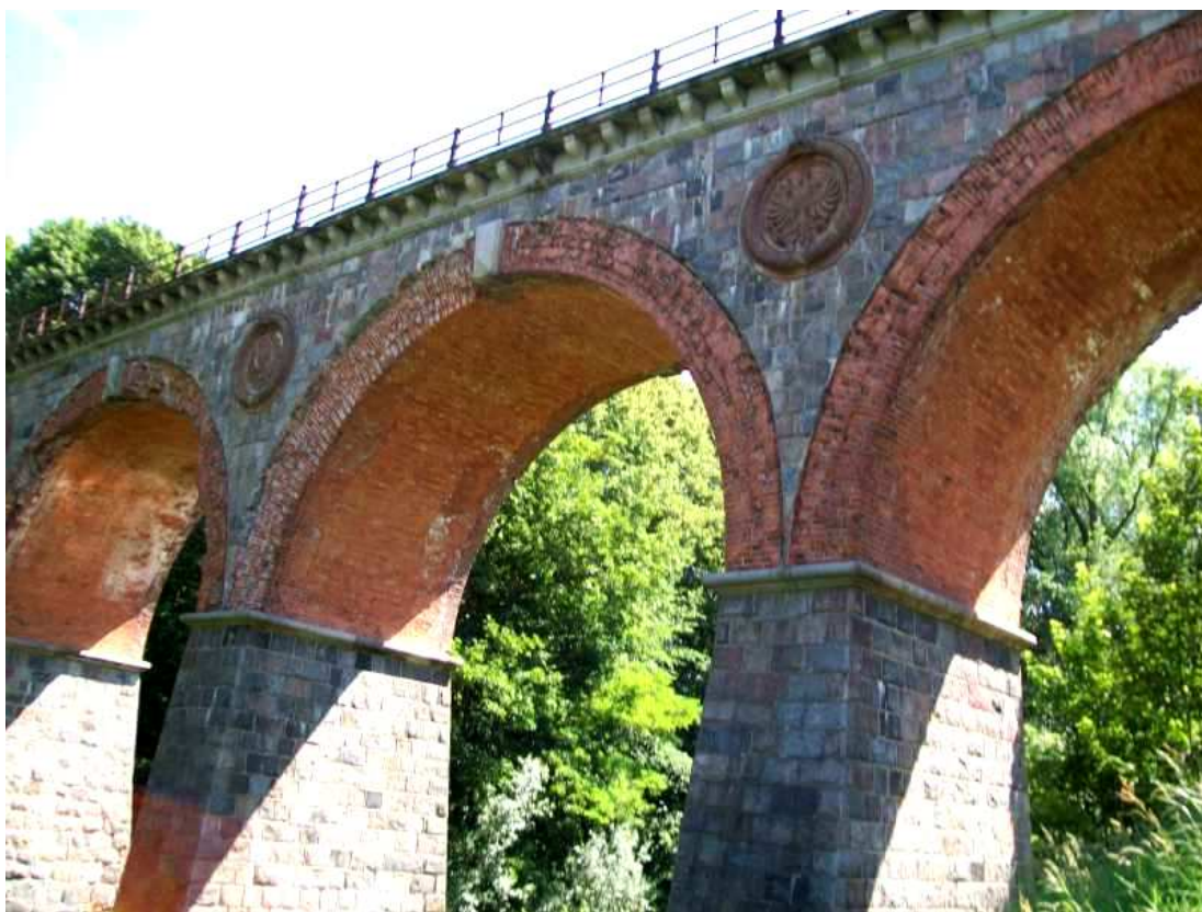
Fot.11. Fragment elewacji mostu, widoczne białe zacieki w górnych partiach – efekt wypłukiwania spoiny.
