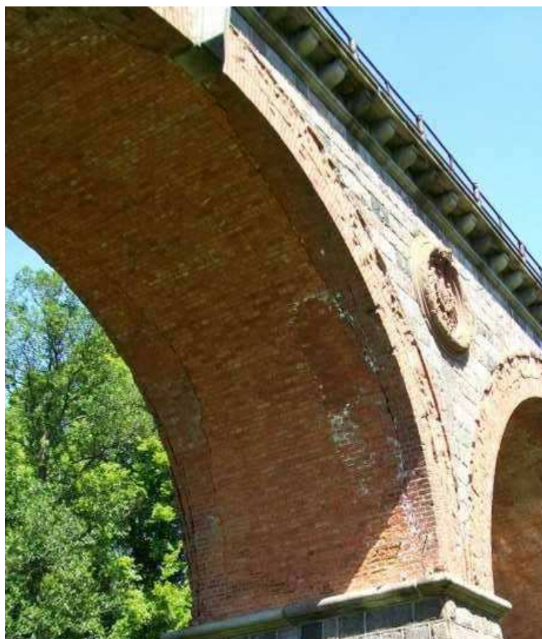
Fot.11. Fragment elewacji mostu, widoczne białe zacieki w górnych partiach – efekt wypłukiwania spoiny.
