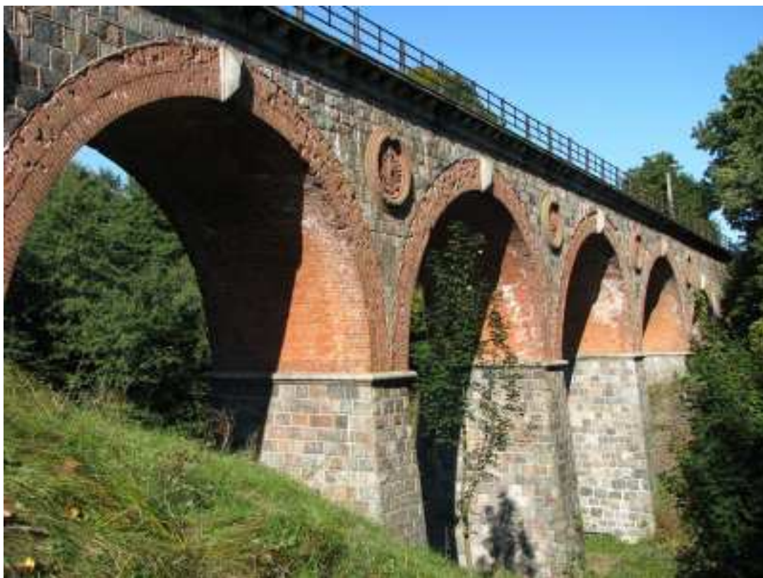
Fot.1 Most w Bytowie, widok ogólny, elewacja wschodnia
