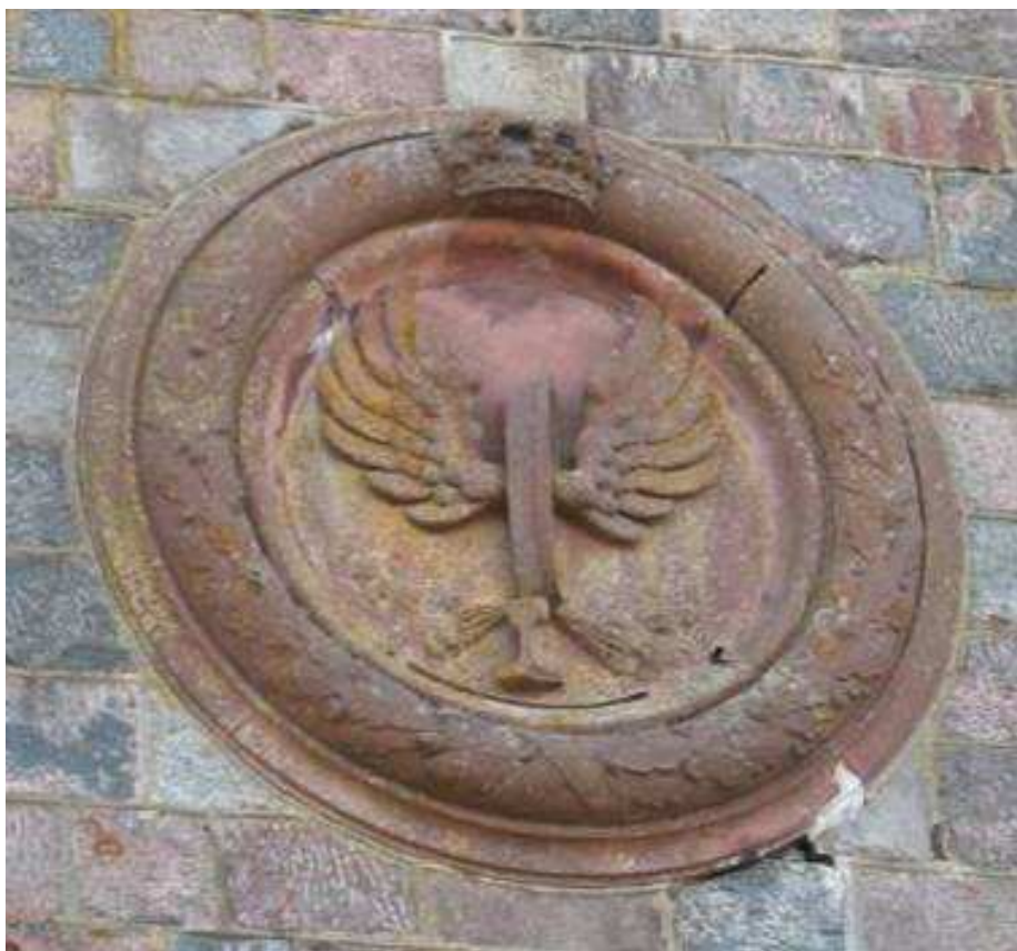
Fot. 10 Medaliony, widoczne wypłukanie powierzchni w górnych partiach
