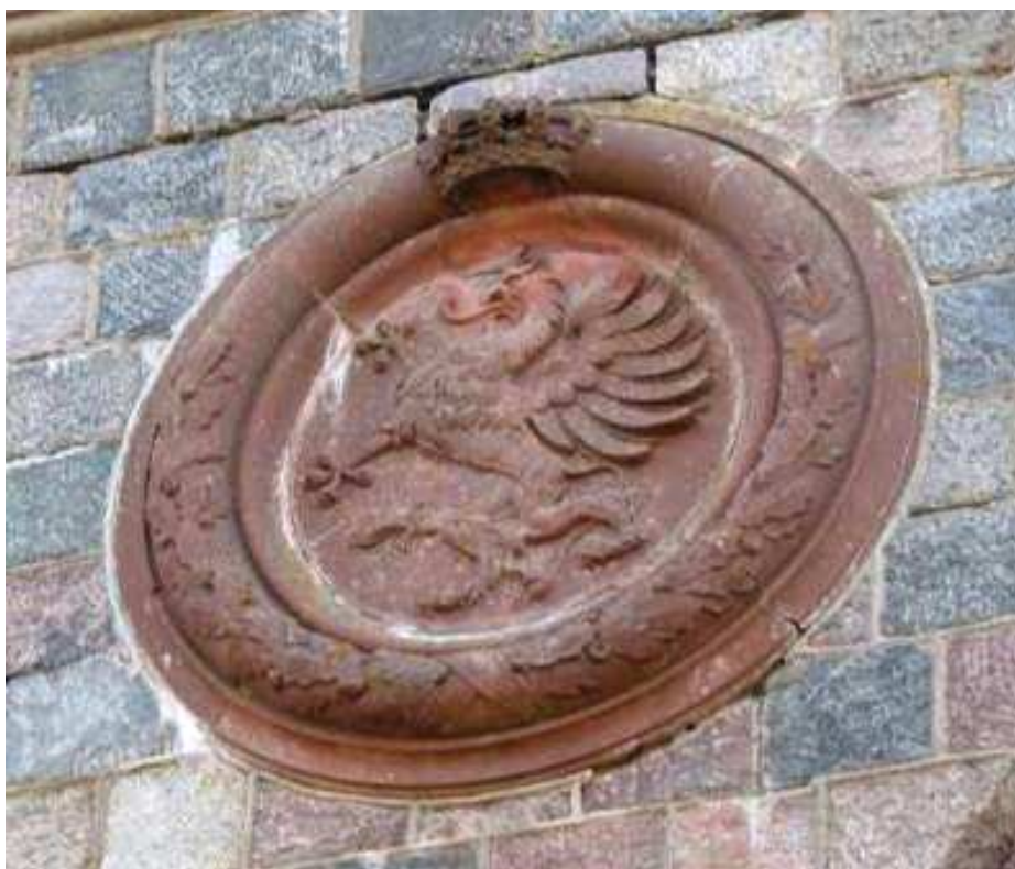
Fot. 10 Medaliony, widoczne wypłukanie powierzchni w górnych partiach
