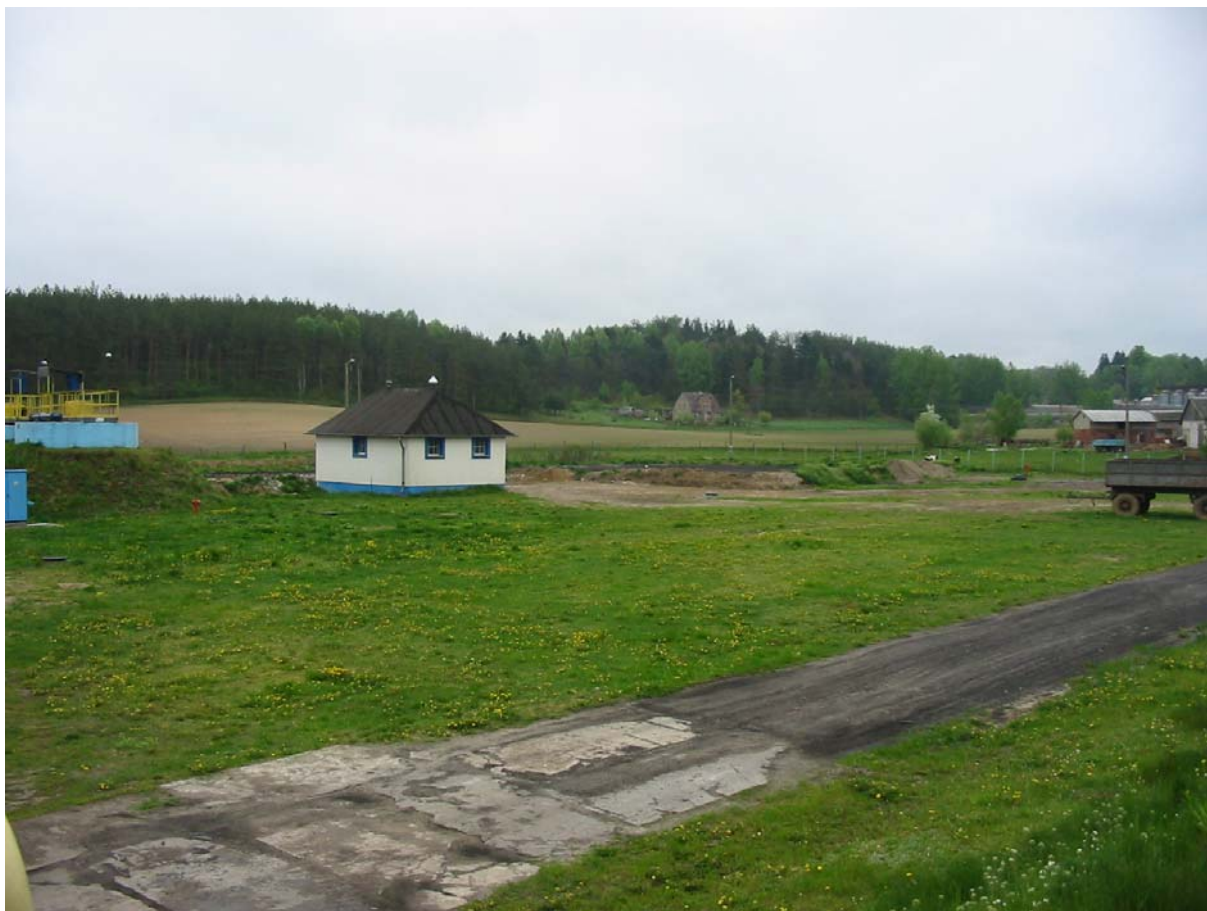
Fot. 2 Teren oczyszczalni ścieków komunalnych w Przyborzycach przewidziany pod budowę kompostowni osadów ściekowych i lokalizację III ciągu technologicznego
